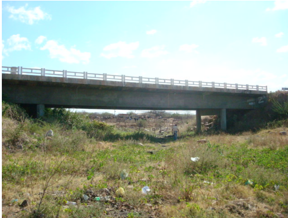
Figura 6 – Vista lateral da ponte de referência.
