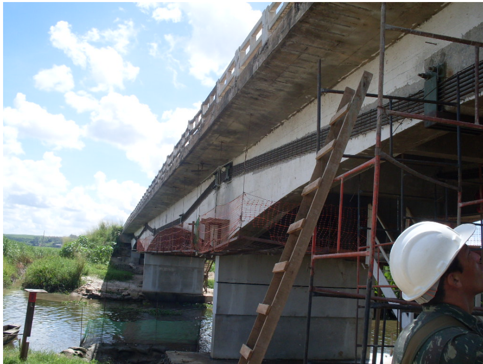
Figura 4 – Reforço das vigas existentes com protensão externa.
